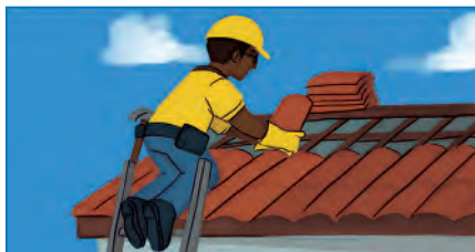
OS TELHADISTAS COLOCAM AS TELHAS SOBRE A ESTRUTURA DE MADEIRA.
