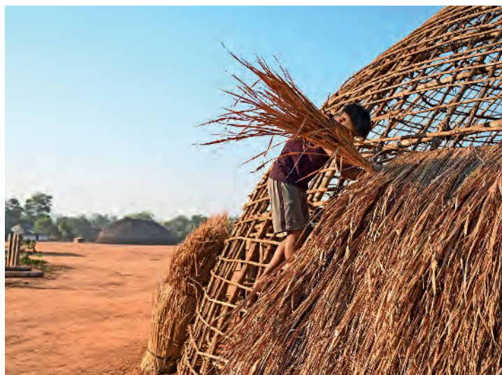
INDÍGENA WAURÁ COBRINDO A ESTRUTURA DE UMA MORADIA COM PALHA, NO MUNICÍPIO DE GAÚCHA DO NORTE, ESTADO DE MATO GROSSO, EM 2024.
